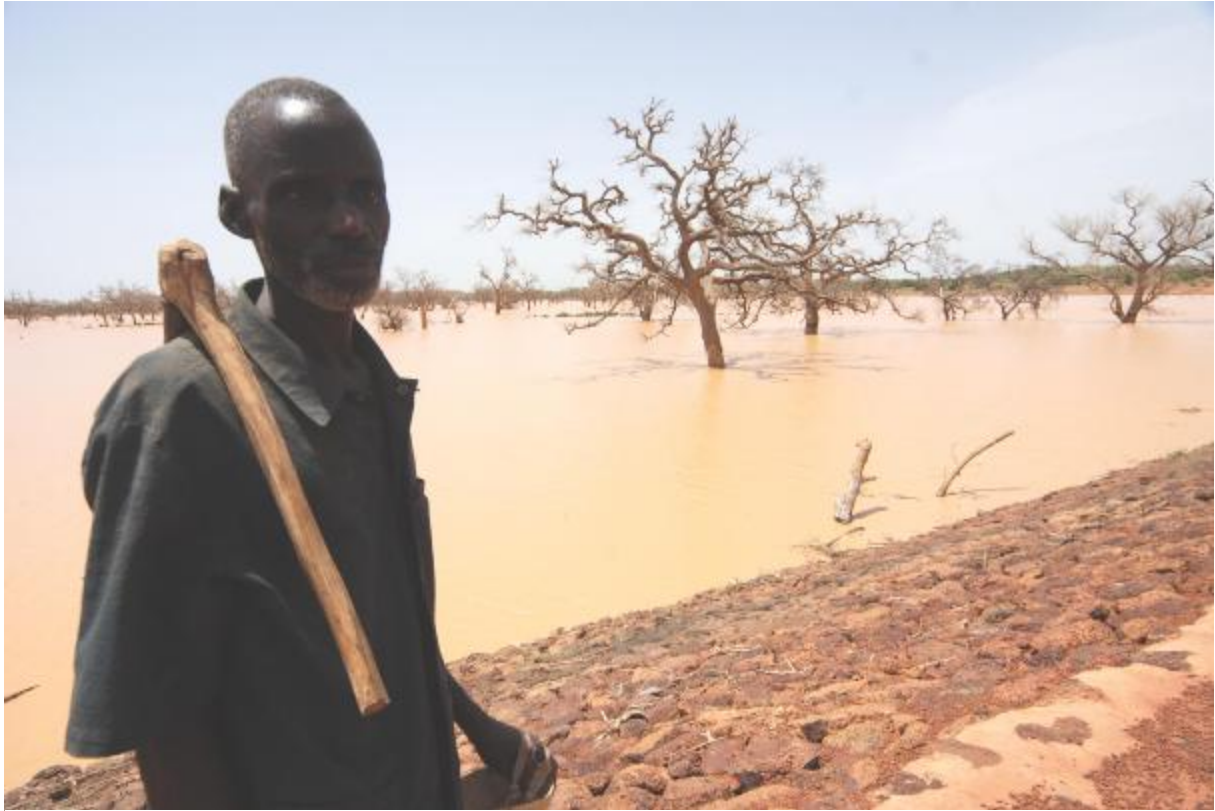
Ein vom Staat gebautes Wasserrückhaltebecken steigert den Ertrag und macht auch Gemüsebau möglich.
