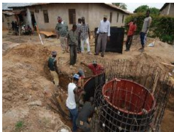
La Suisse soutient l'autorité de la ville de Dodoma responsable de l'eau afin de développer le réseau d'évacuation dans les quartiers.
